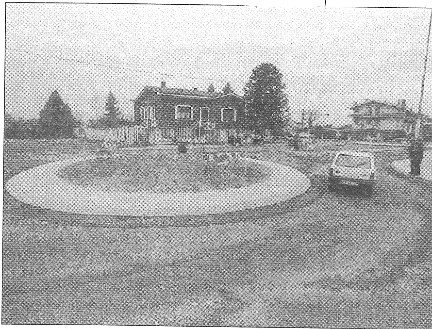
Le due rotonde appena ultimate sulla strada per Cassano Magnago
