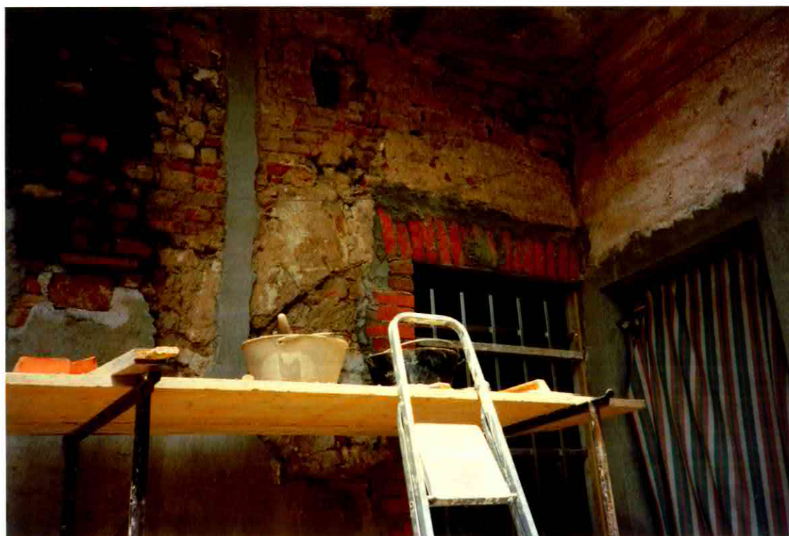
1992 Vicolo Beunetai cortile case 4 santi Particolare della volta rinvenuta
