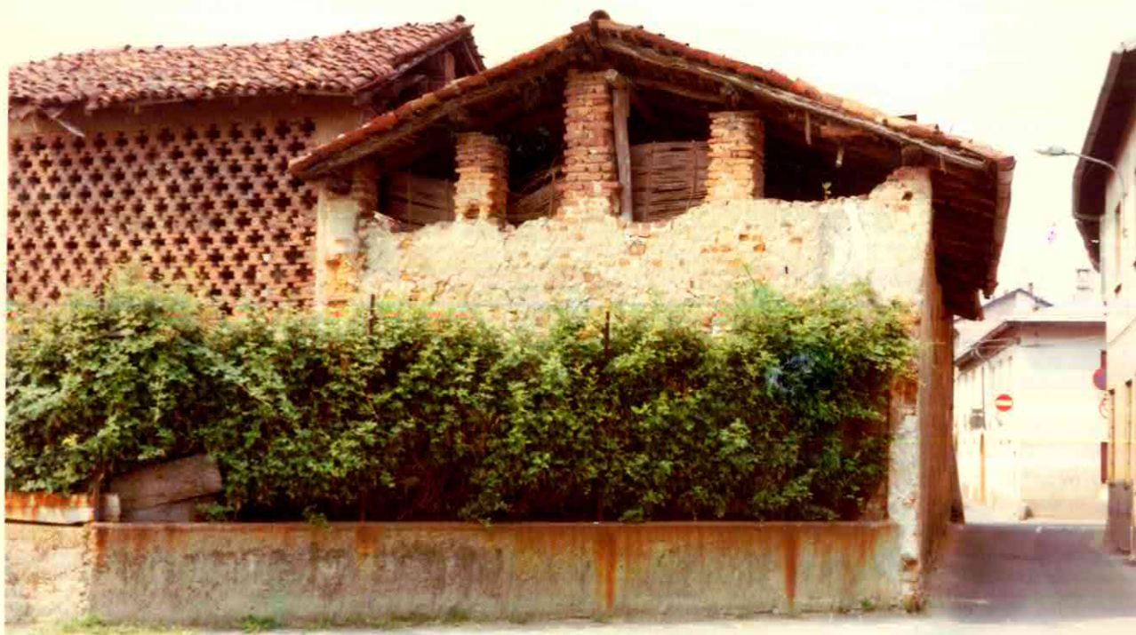
CASA MOCCHETTI (v. Silvio Groyetti) la shoreatura vista de S.S. Groyetti 1970 (Stalle proprietà Mocchetti)
