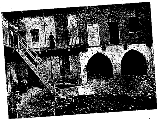
Fig. 22. — CASA VISMARA — Durante la demolizione si scoprono a piano terreno verso gli archi del porticato del Sec. XV.
