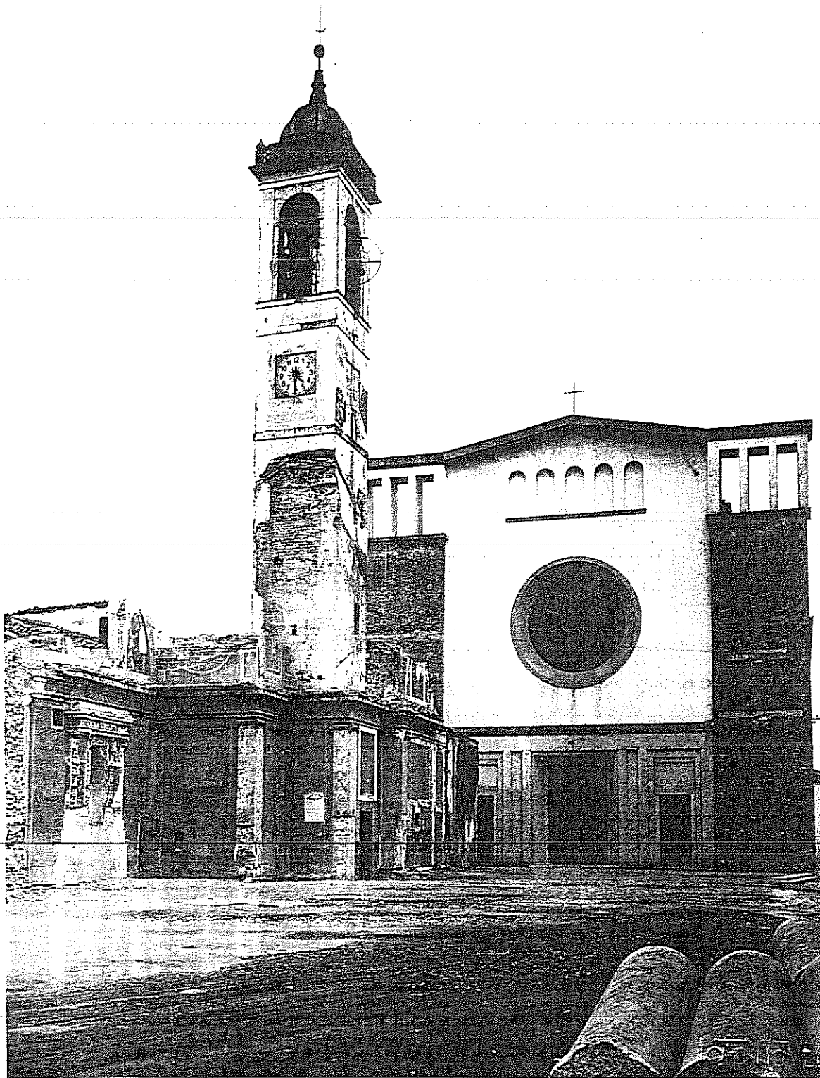
Nuova chiesa parrocchiale. Di fronte la vecchia Parrocchiale parzialmente demolita. 18 febbraio 1949
