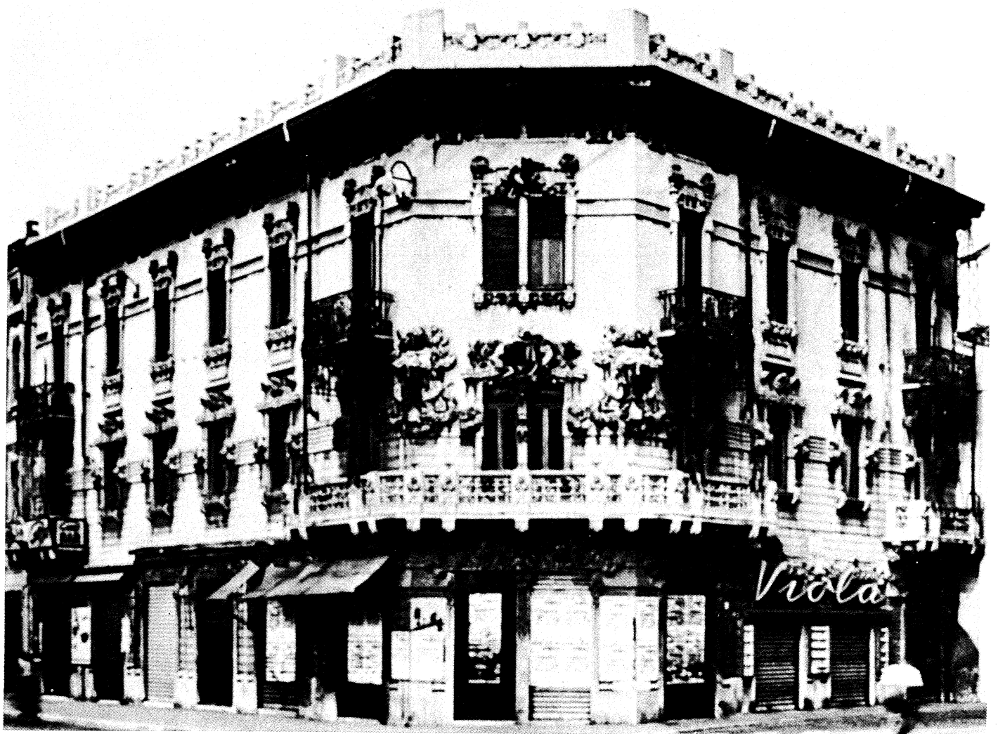
- Casa Rena, 1906-1907 - (demolita)
