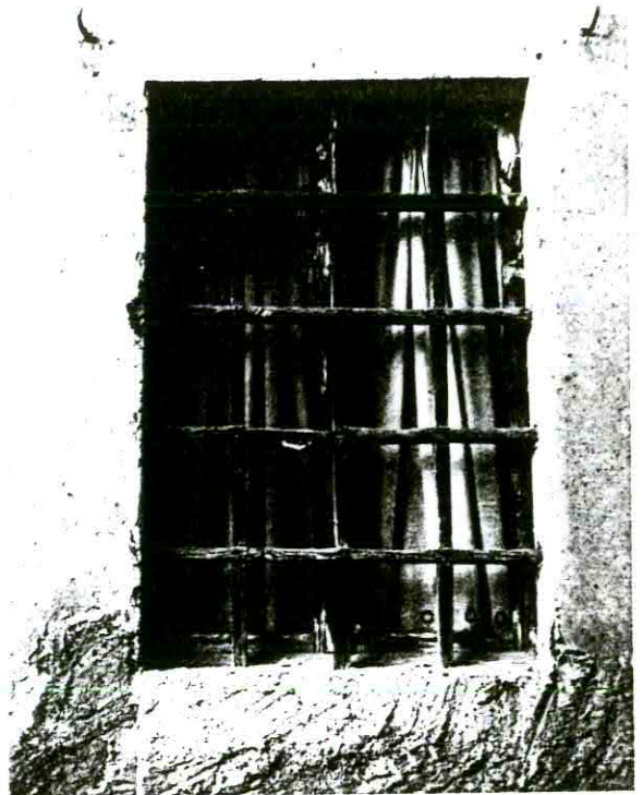
Finestra sulla strada con grata in legno.
