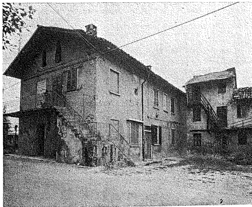
Cascina Romanò, di prossima demolizione
