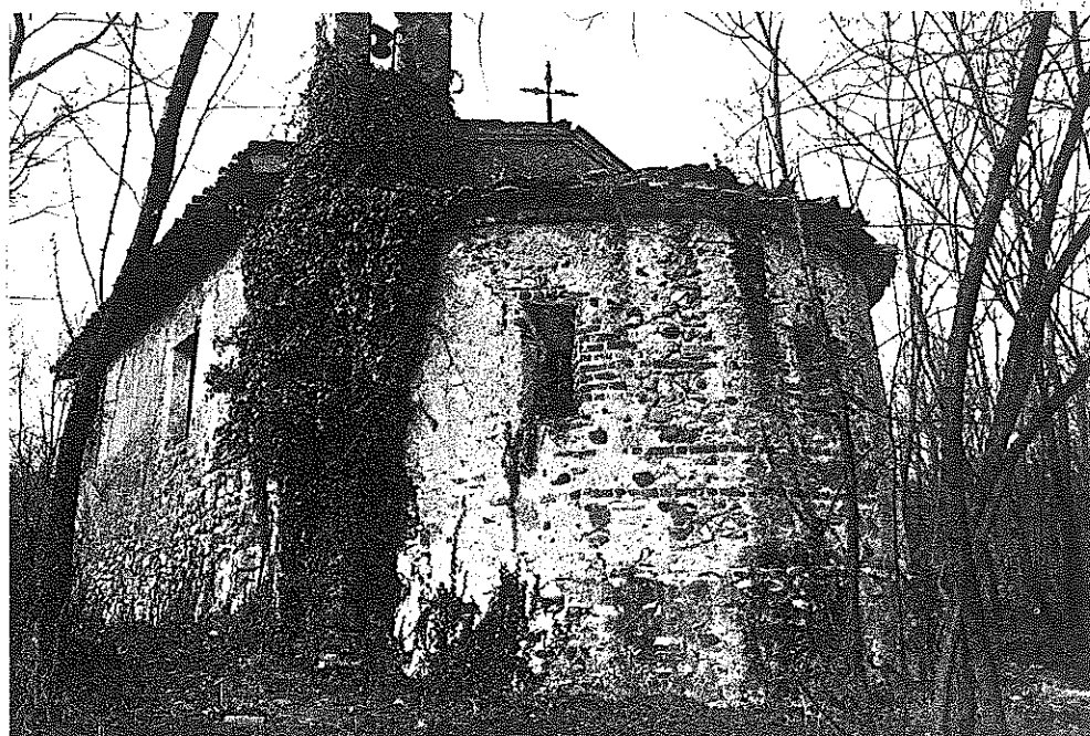
Fig. 2 - S. Michele - Il fianco meridionale e l'abside con le due finestrelle romaniche. L'edera avvolge completamente l'attacco dell'abside con l'aula.
