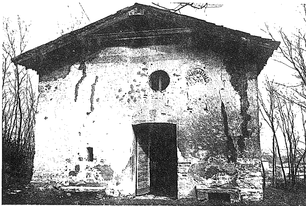
Fig. 4 - S. Michele - La facciata con l'ingresso e la finestrella tonda spostati verso sud. Sopra la piccola finestrella rettangolare devozionale compaiono due lesioni sigillate che mi hanno indicato l'esistenza delle aperture originarie.
