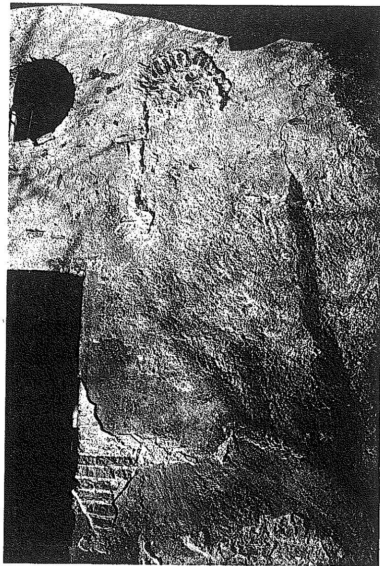
Fig. 14 - S. Michele - Parte meridionale della facciata con gli assaggi al perimetro della finestra prelongobarda.
