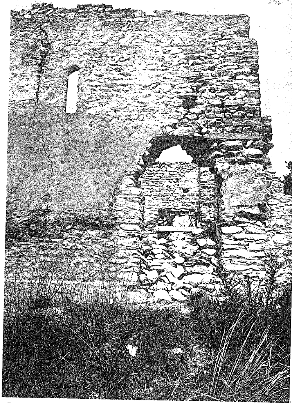
Fig. 29 - St-Félix - Parete meridionale verso l'abside. Si noti la rientranza dello spigolo in alto per ridurre lo spessore della parete orientale sopra l'arco absidale. L'ingresso ha la spalla destra originaria e quella sinistra rifatta.
