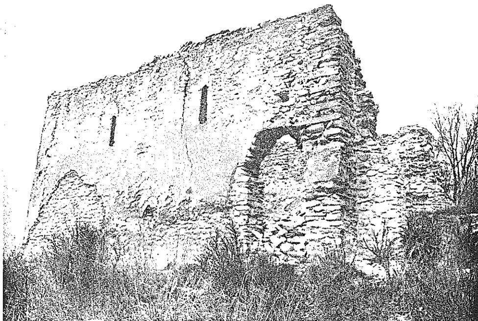
*Fig. 36 - St-Félix - La parete meridionale con i monconi dell'abside (in parte recentemente ripristinati). Sono visibili le due strette aperture altomedioevali ottenute rimpicciolendo quelle originali molto più ampie e facilmente individuabili.*
