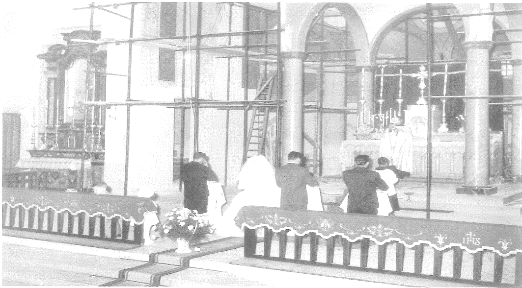
Tra gli anni 1962-64 le sante celebrazioni si svolgono sotto le impalcature. La chiesa è ancora un "cantiere" perchè si sta lavorando per il ciborio e gli affreschi, realizzati dal pittore legnanese Mosè Turri.
