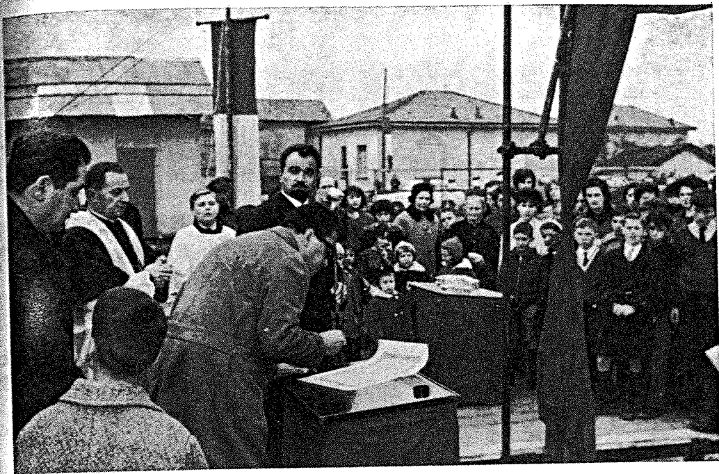
Posa della prima pietra della nuova Scuola Materna
