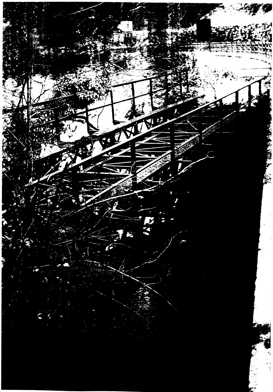
Ponte di ferro sul Tresa.
