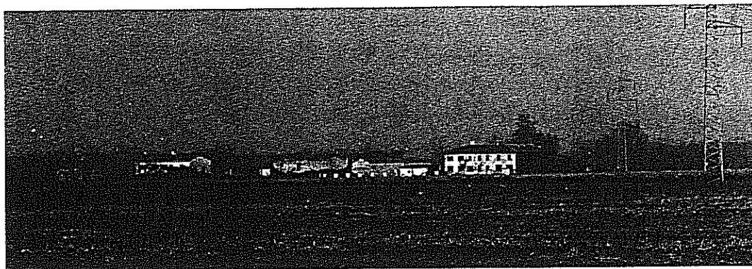
Una veduta della cascina Valdarenne oggi.
