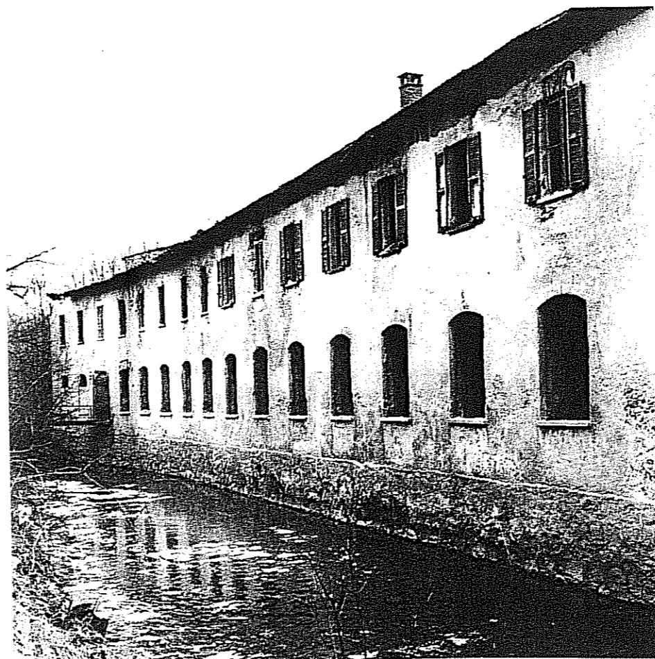
Filatoio di cotone Varenna di Gurone, prospetto sul fiume.
